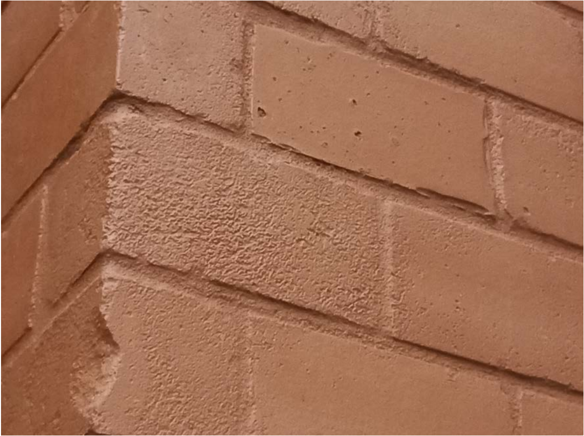
Fotografija Nr.1 Įsigeriančiais dažais, tvirtu sluoksniu padengtos raudonos keraminės plytelės ir jų siūlės, autentiškos siūlės papildomai užpildytos glaistu
