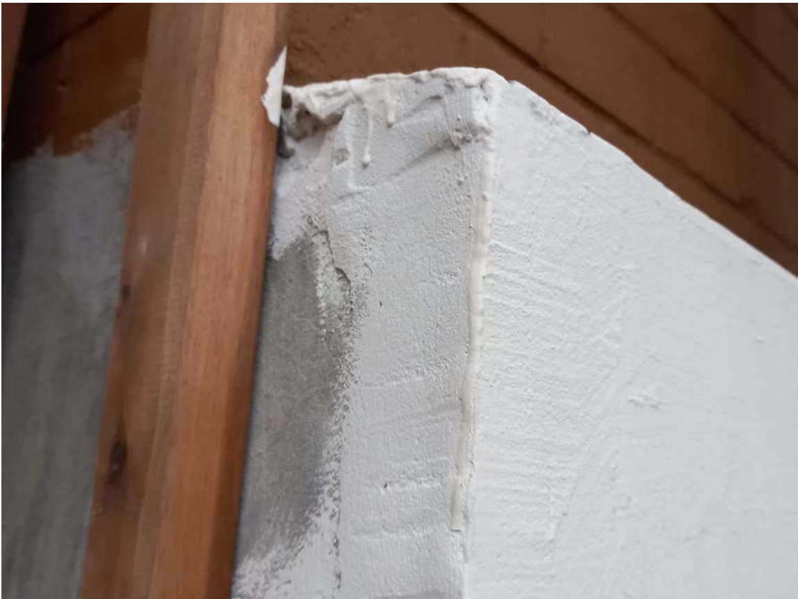
Fotografija Nr.2 Pilko cemento tinko apdaila užglaistyta ir nudažyta balsvais dažais
